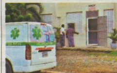
Instalaciones del INACIF en Santiago. ARCHIVO
